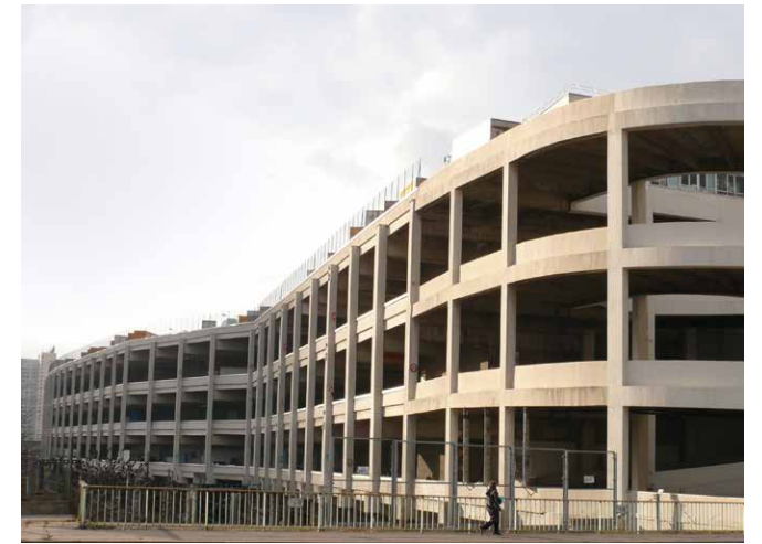
Abbildung 3: Entrepôt Ney, errichtet 1976 in Paris. Quelle: Jacques Mossot/Structurae
