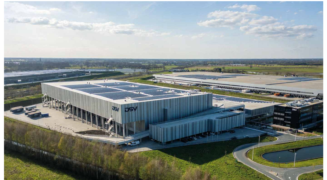
Projektfoto: DSV Venlo 5, © Unibau Gewerbebau GmbH
