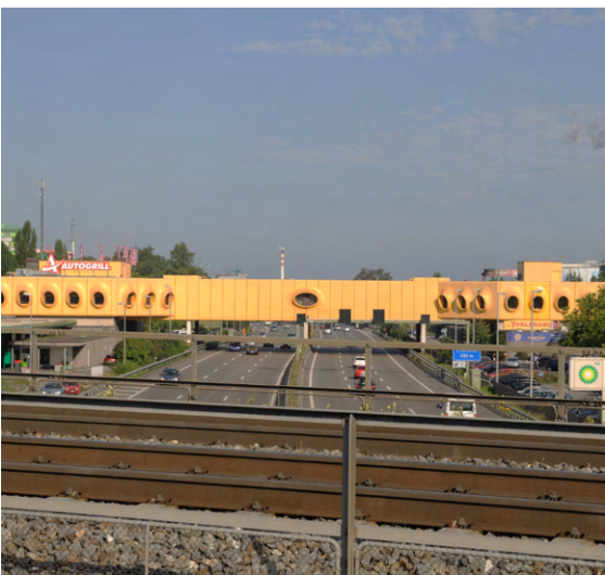
Abb. 80: Patteln Autobahnbrücke (Quelle: wikimedia , CC BY-SA 3.0)
